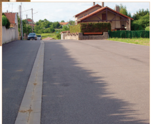
Réfection de la chaussée rue du Champ Tortu
