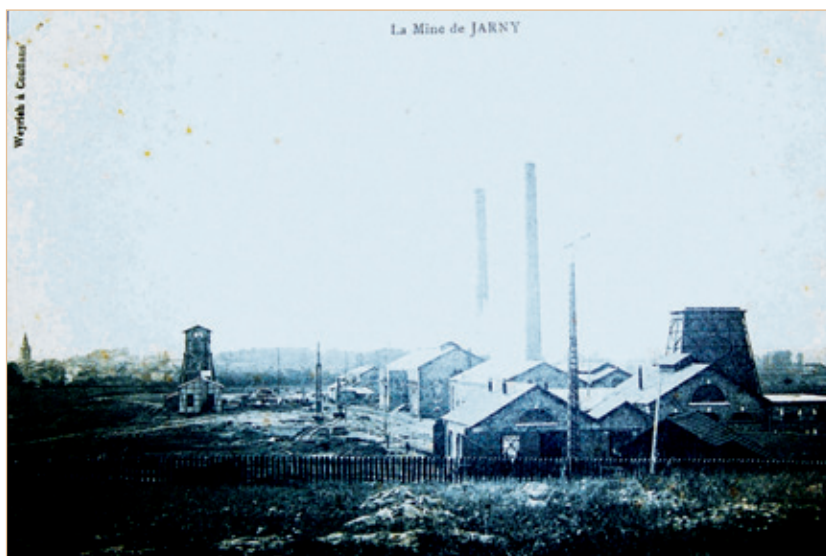
L'une des plus anciennes photographies de la mine de Jarny. Si la plupart des bâtiments et les deux grandes cheminées sont déjà sortis de terre, les chevaux ne sont encore que d'énormes structures de bois. A l'arrière-plan, le vieux clocher de Jarny semble veiller, de loin, sur les mineurs.
