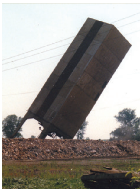
Démolition du skip
