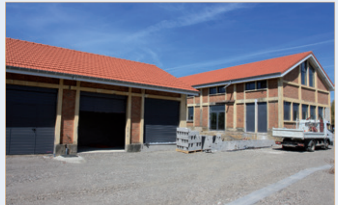
Réhabilitation du carreau de mine
