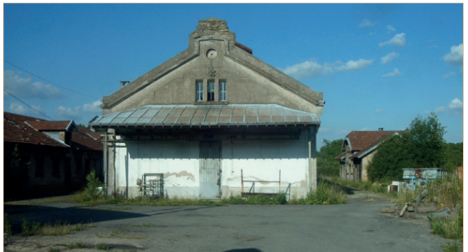
Abattoir avant la démolition de l'auvent et des bâtiments annexes
