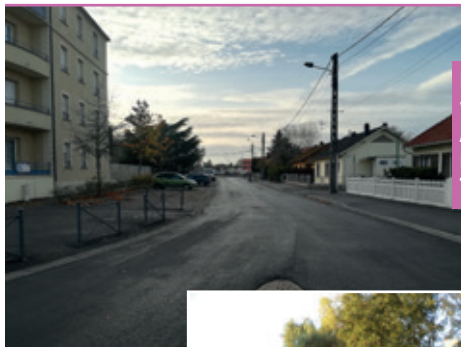
Rénovation de la voirie de la rue Albert 1 er (entre les rues Mozart et de la Tuilerie)
