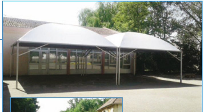
Préau de l'école Yvonne Imbert dans le quartier des Lotissements, pour un coût de 25 000 €
