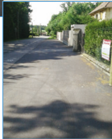
Trottoir rue du Bois du Four dans le quartier de Droitaumont, à hauteur de 14 000 €
