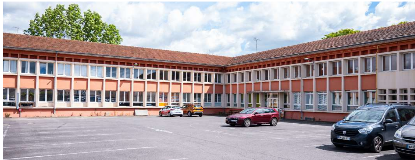
Ci-dessus : Les travaux de transformation de l'ancien lycée Anne Frank en Maison des associations et de la vie citoyenne ont démarré en avril 2010 pour une durée d'un an et demi. Inauguré le 19 novembre 2011, le nouveau bâtiment abrite une quinzaine d'associations rue de la Commune de Paris.
