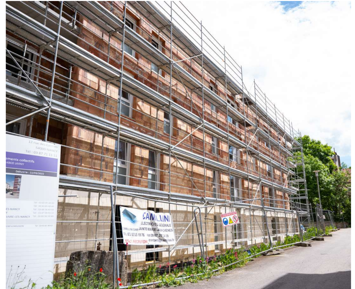
Ci-dessus : Construction en cours d'un immeuble de 31 logements collectifs et d'un parking aérien de 31 places, rue Jeanne D'Arc. Recouvert d'une toiture en tuiles terre cuite, le bâtiment de 4 niveaux (rez-de-chaussée + 3 niveaux) est en forme de L.
