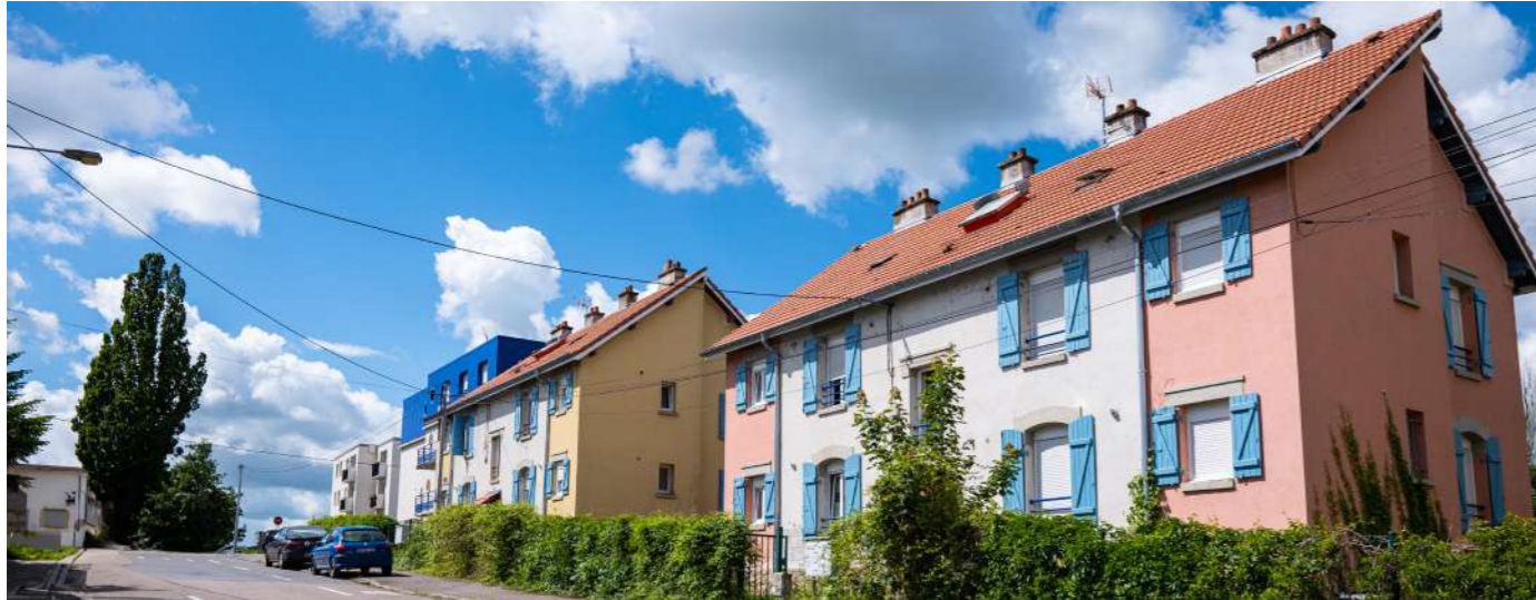
Ci-dessus : Réhabilitation thermique complète et amélioration de 32 logements collectifs et 4 logements individuels dans la rue Pierre Sépard durant l'année 2022. La réhabilitation de ces 190 logements, collectifs et individuels, est conduite par Batigère Grand Est. La Ville accompagne ces travaux pour améliorer le cadre de vie : enfouissements, espaces verts, voirie...
